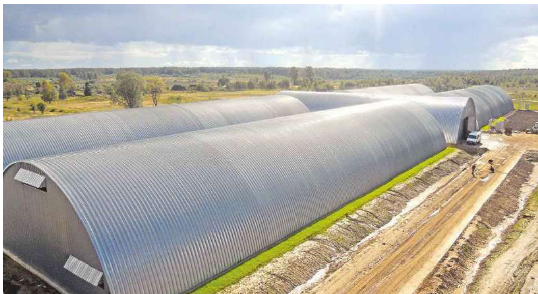
Рисунок 1 - Бескаркасная арочная конструкция картофелехранилища
