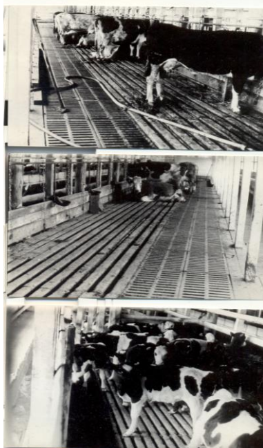
Рис. 3. Общий вид помещений коровника и телятника с решетчатыми полами из модифицированной древесины
