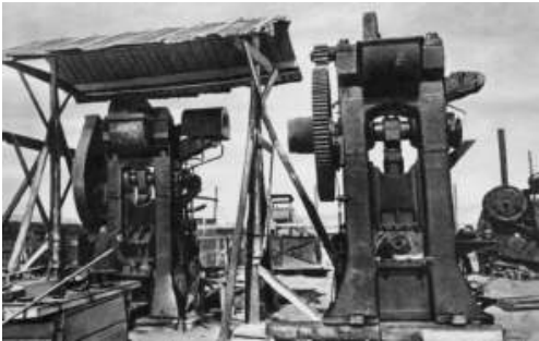
Монтаж оборудования на эвакуированном заводе. Казахстан. 1942 г.
