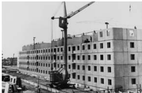
Строительство пятиэтажного жилого дома. Город Волжский
