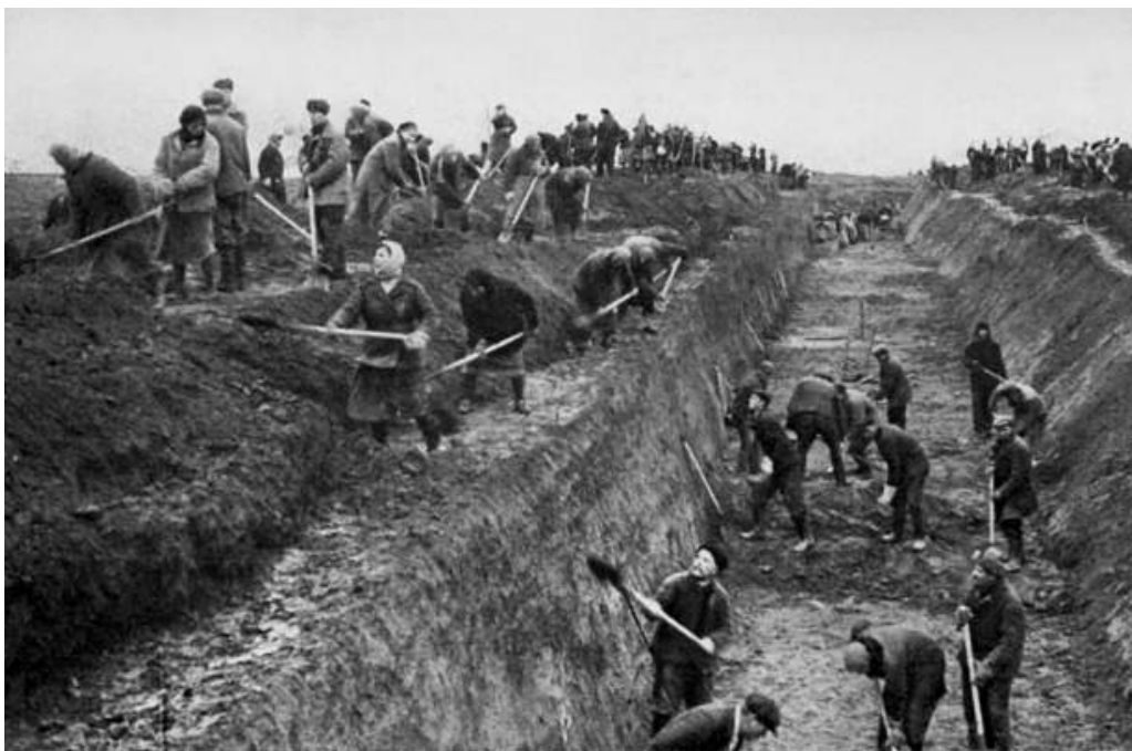
Строительство оборонительных сооружений под Москвой. Осень 1941 г.
