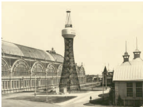
Гиперboloидная башня. Инженер В. Г. Шухов
