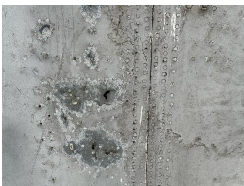
Рисунок 4 — Коррозия фюзеляжа самолета
