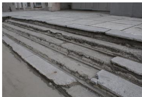
Рис. 4. Крыльцо у бокового входа
