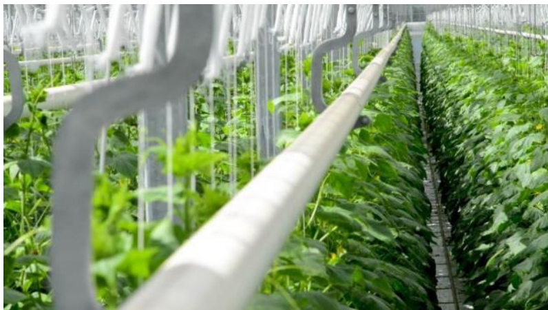
Рисунок 1. Магистраль из полиэтиленовых труб для подачи \text{CO}_2 [5].
