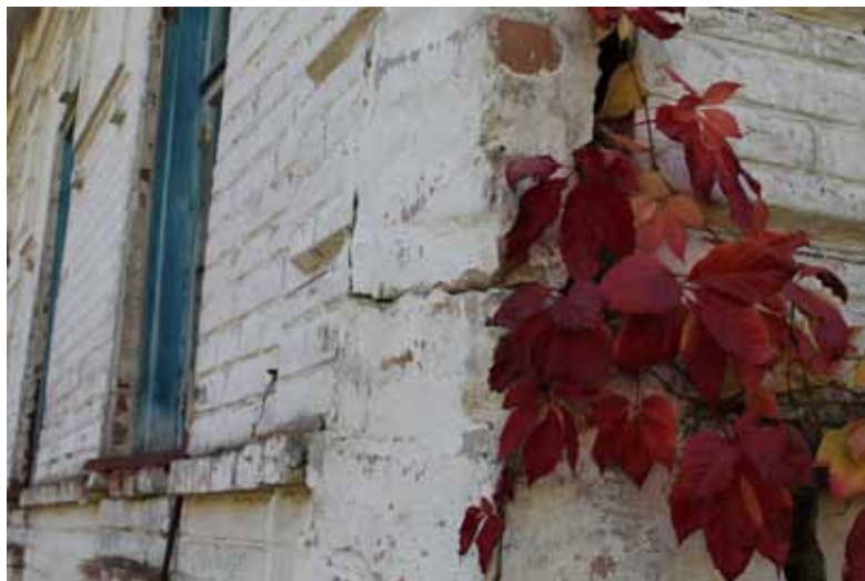
Рис. 3. Здания деревянные, обложенные кирпичом
