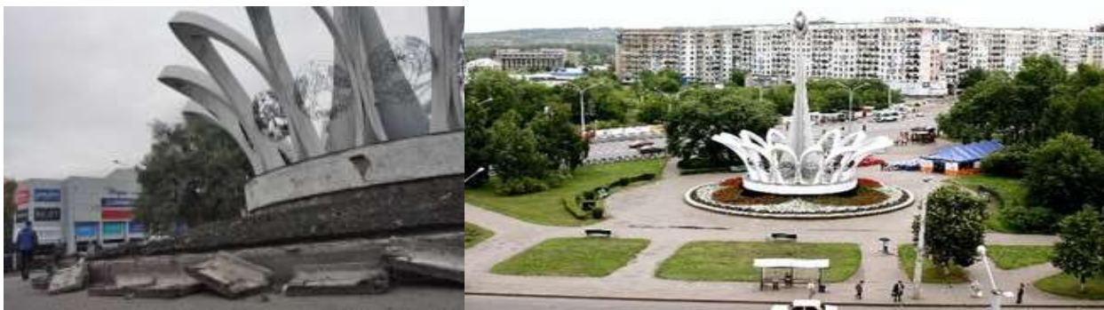
Рис.1. Внешний вид парка до реконструкции
