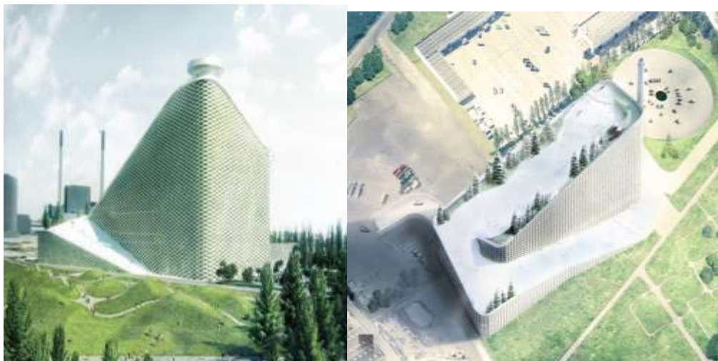
Рис. 3. Мусоросжигательный завод «AmagerBakke» [5]
