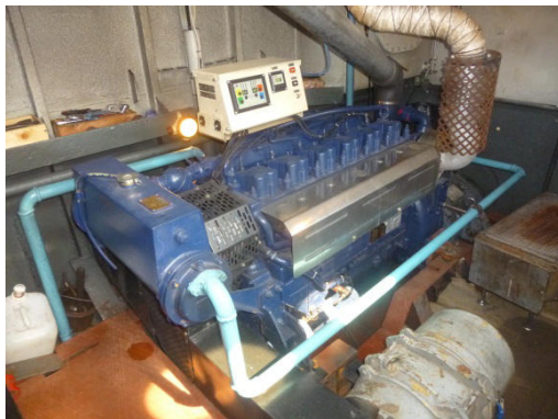
Рисунок 1 – Общий вид дизель-редукторного агрегата буксира «БЛПК-17»
