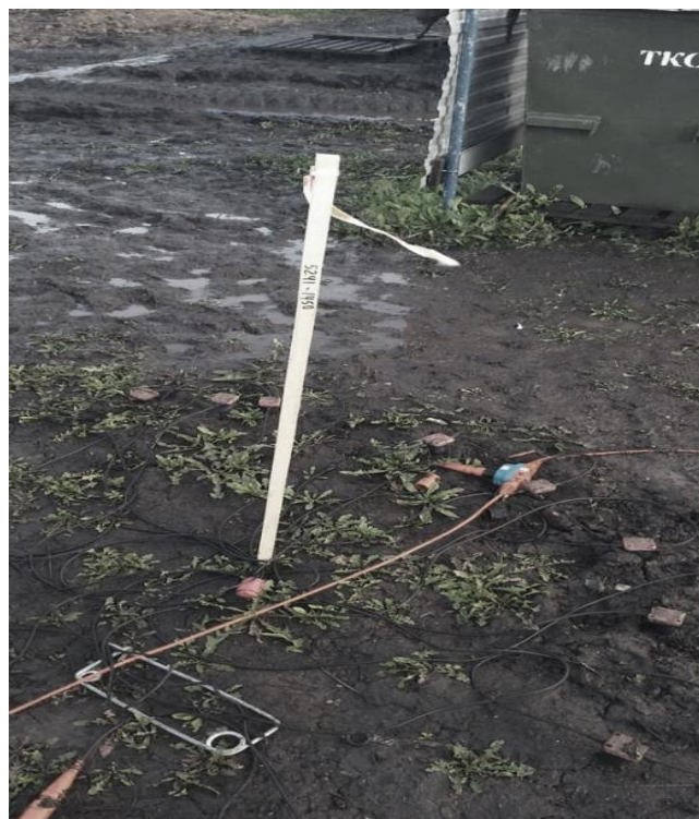
Рисунок 2 – Закрепление пикета на местности деревянным колышком
