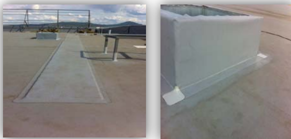
Рис.1. Примеры качественного выполнения мембранной кровли
